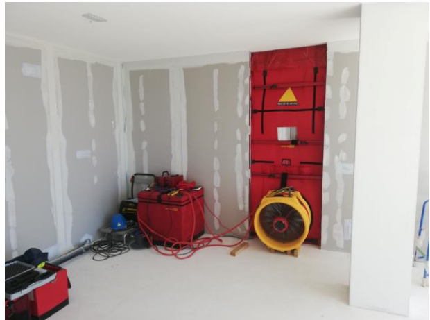
Afbeelding 2 – In-situ-test met blowerdoor
